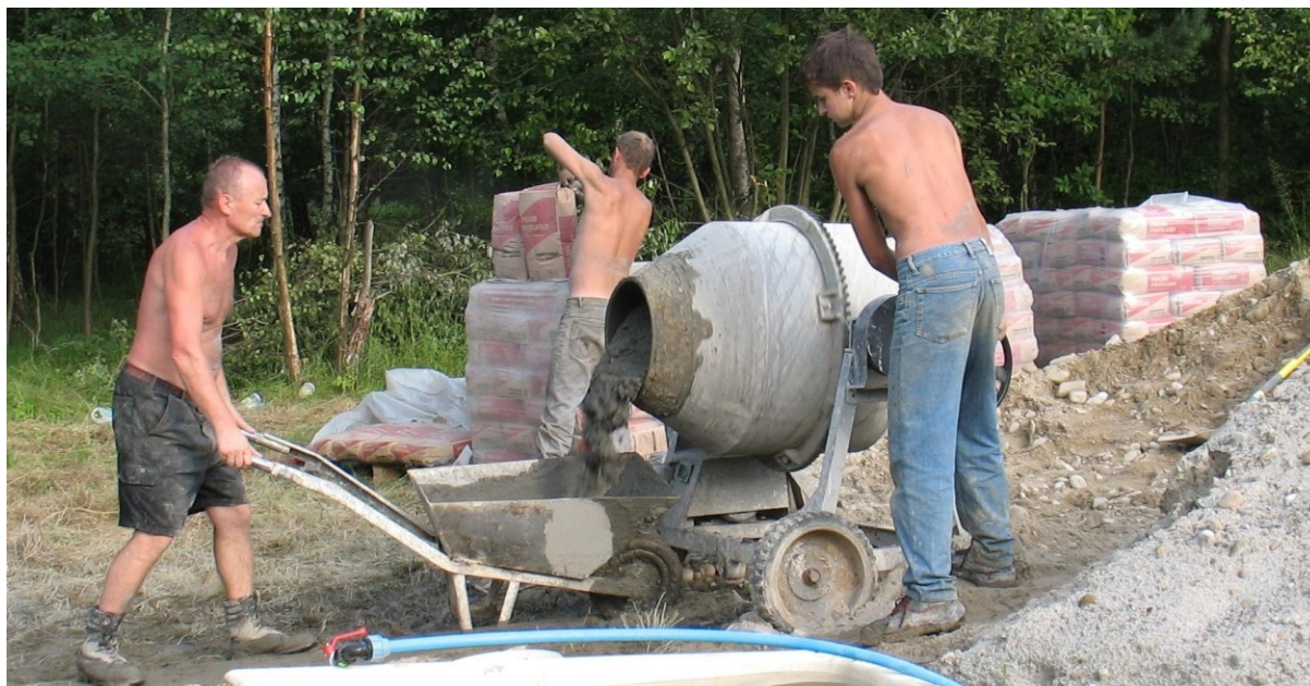
Mieszanie i wylewanie betonu metodą klasyczną. (fot. A.Kołodziejczyk)
