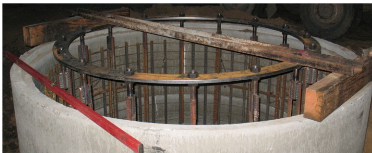
Zbrojenie fundamentu. (fot. B.Wszolek)
