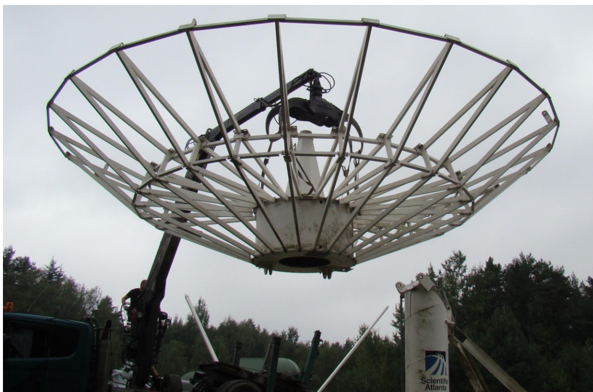
Przenoszenie przy pomocy dźwigu wcześniej wypoziomowanej czaszy w stronę uchwytów na nodze. Operacja była bardzo niebezpieczna. (fot. B. Wszolek)
