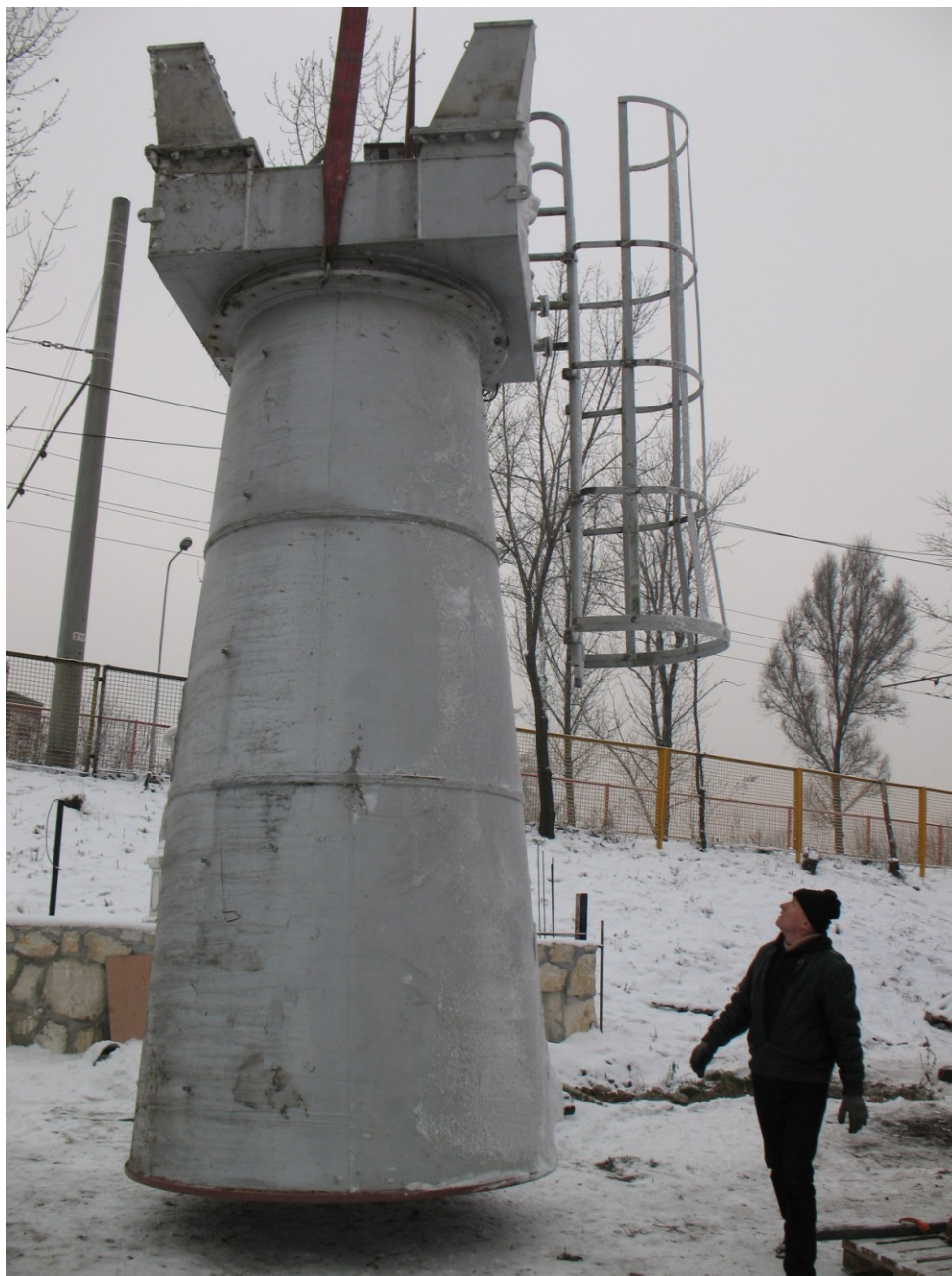
Noga radioteleskopu w drodze na fundament. (fot. K.Bączek)
