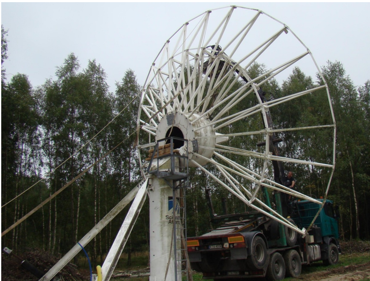
Operacja ustawiania czaszy do pozycji pozwalającej na zamontowanie siłownika odpowiedzialnego za pionową regulację położenia anteny. (fot. B. Wszolek)
