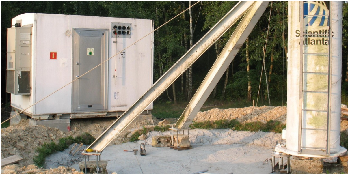
Wygląd podstawy czaszy przed drugą fazą zbrojenia i betonowania. W tle zainstalowany kontener serwerowni. (fot. B. Wszolek)
