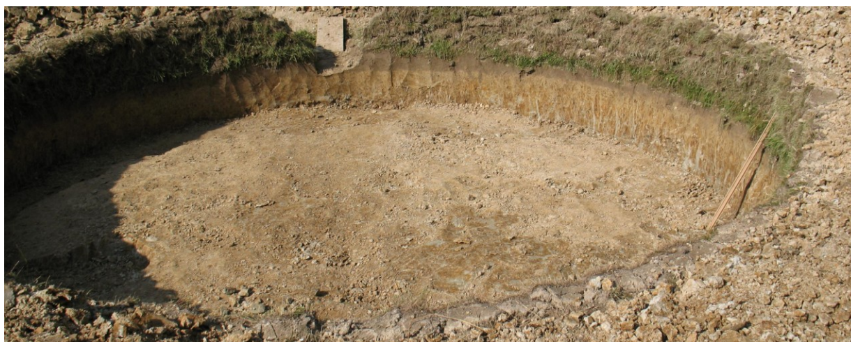
Wykop pod fundament radioteleskopu RT-9. (fot. B. Wszolek)
