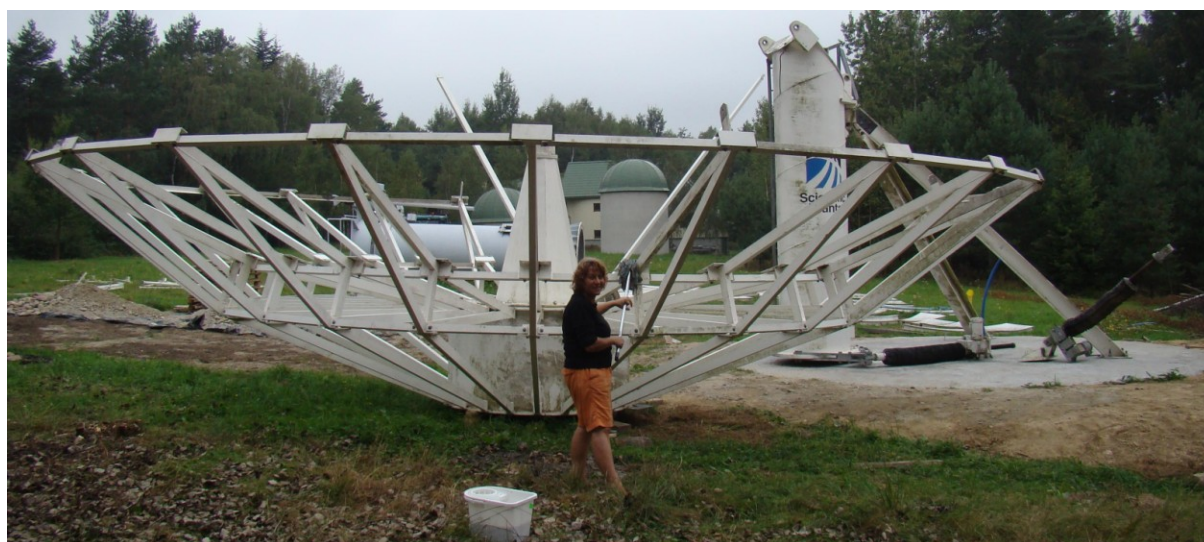
Magdalena Wszolek w akcji mycia szkieletu czaszy przez montażem. (fot. B.Wszolek)
