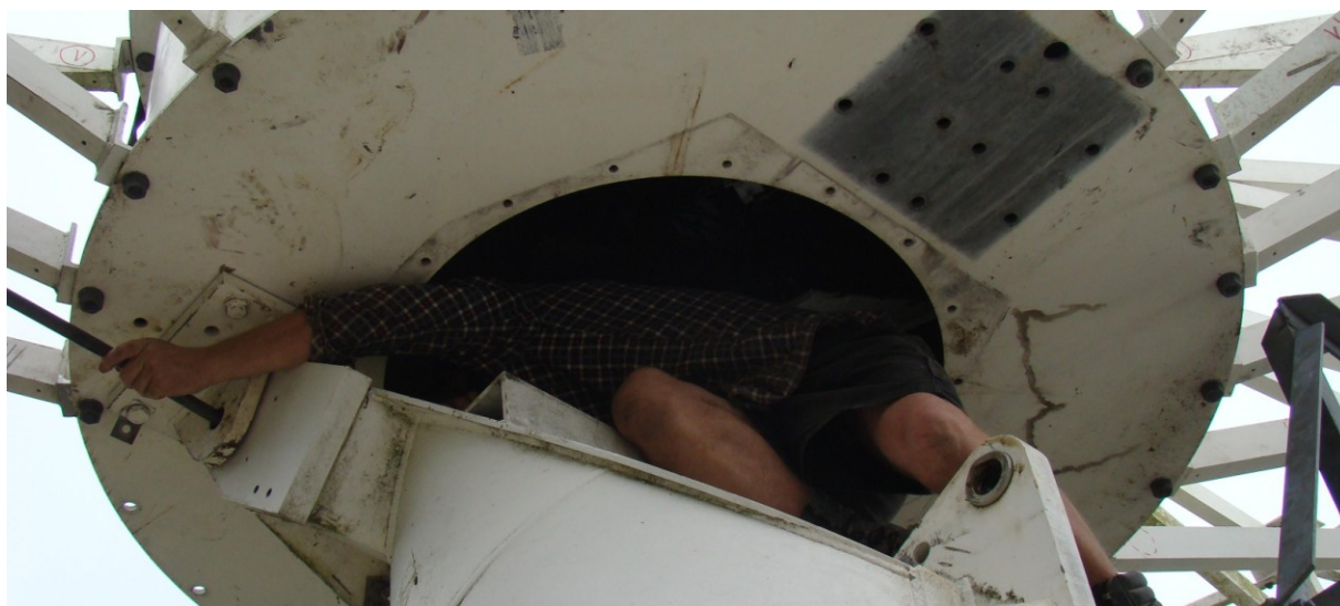
Akcja idealnego dopasowania otworów dla wbicia sworzni mocujących. Praca pod wiszącą czaszą. Drobny defekt dźwigu podczas tej rozciągłej w czasie operacji mógł spowodować tragedię. (fot. M. Wszolek)
