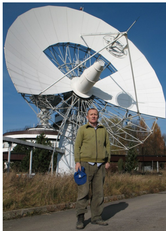
W trakcie demontażu. (fot. K. Wszolek)
