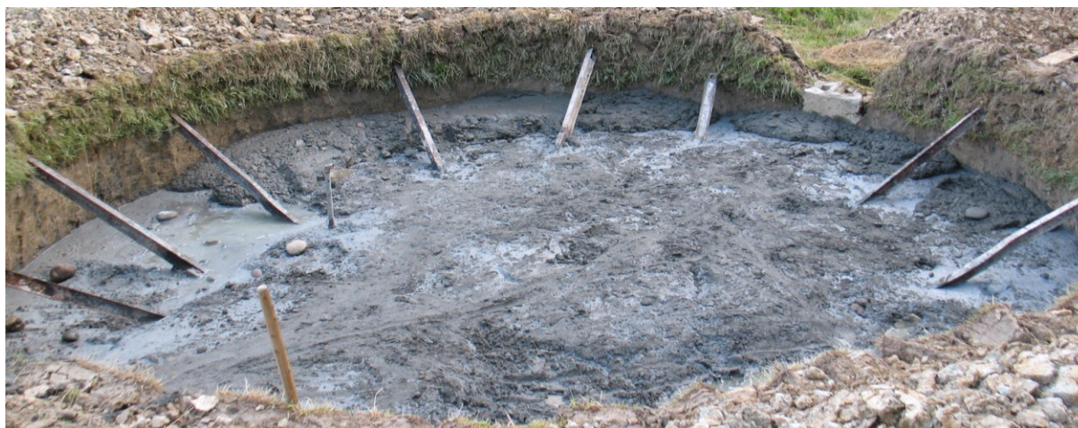
Wypełnianie wykopu betonem. (fot. B.Wszolek)
