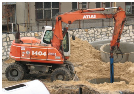
Wykop. (fot. B.Wszolek)
