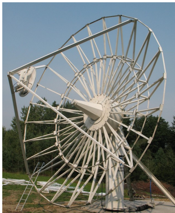
Szkielet czaszy gotowy do przykręcania paneli. (fot. B. Wszolek)
