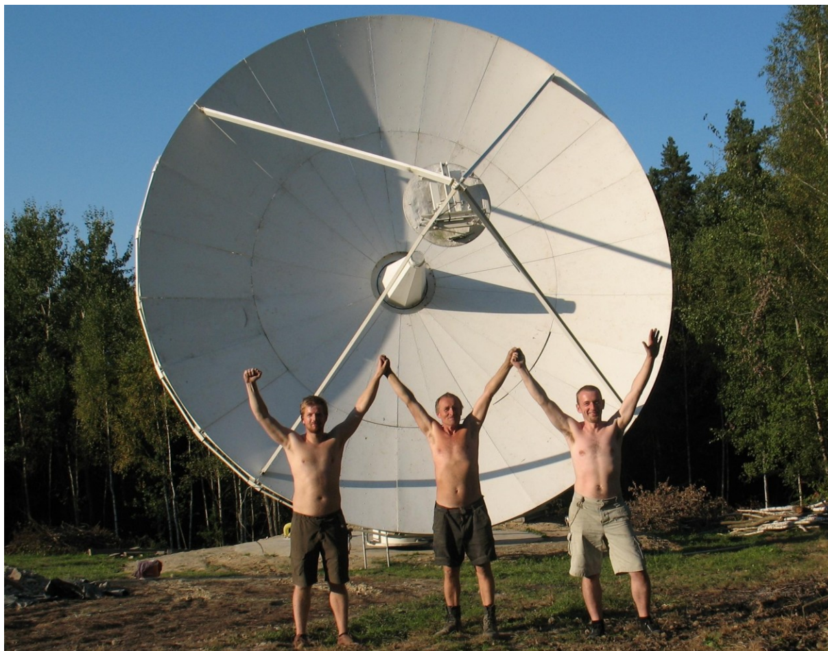
Szczęśliwy finał montażu paneli. Triumfują od lewej: Paweł Barszcz, Bogdan Wszolek i Bogumił Bubniak. (fot. B.Wszolek)
