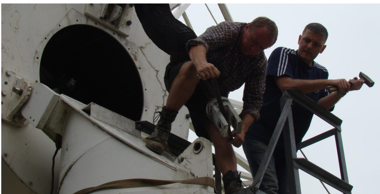
Montaż siłownika do pionowej regulacji anteny. W akcji Bogdan Wszolek i Sławomir Surowiec. (fot. M. Wszolek)
