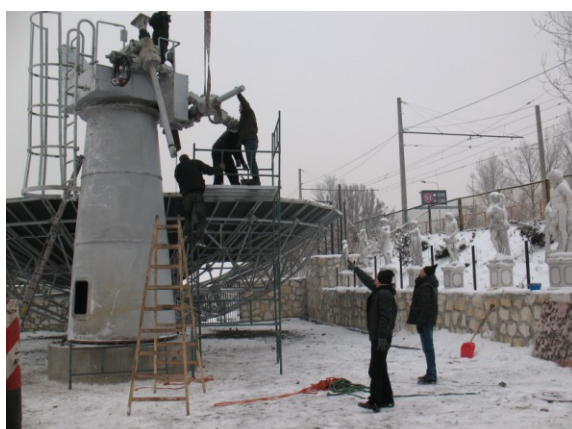
Dokręcanie siłownika (fot. K.Bączek)
