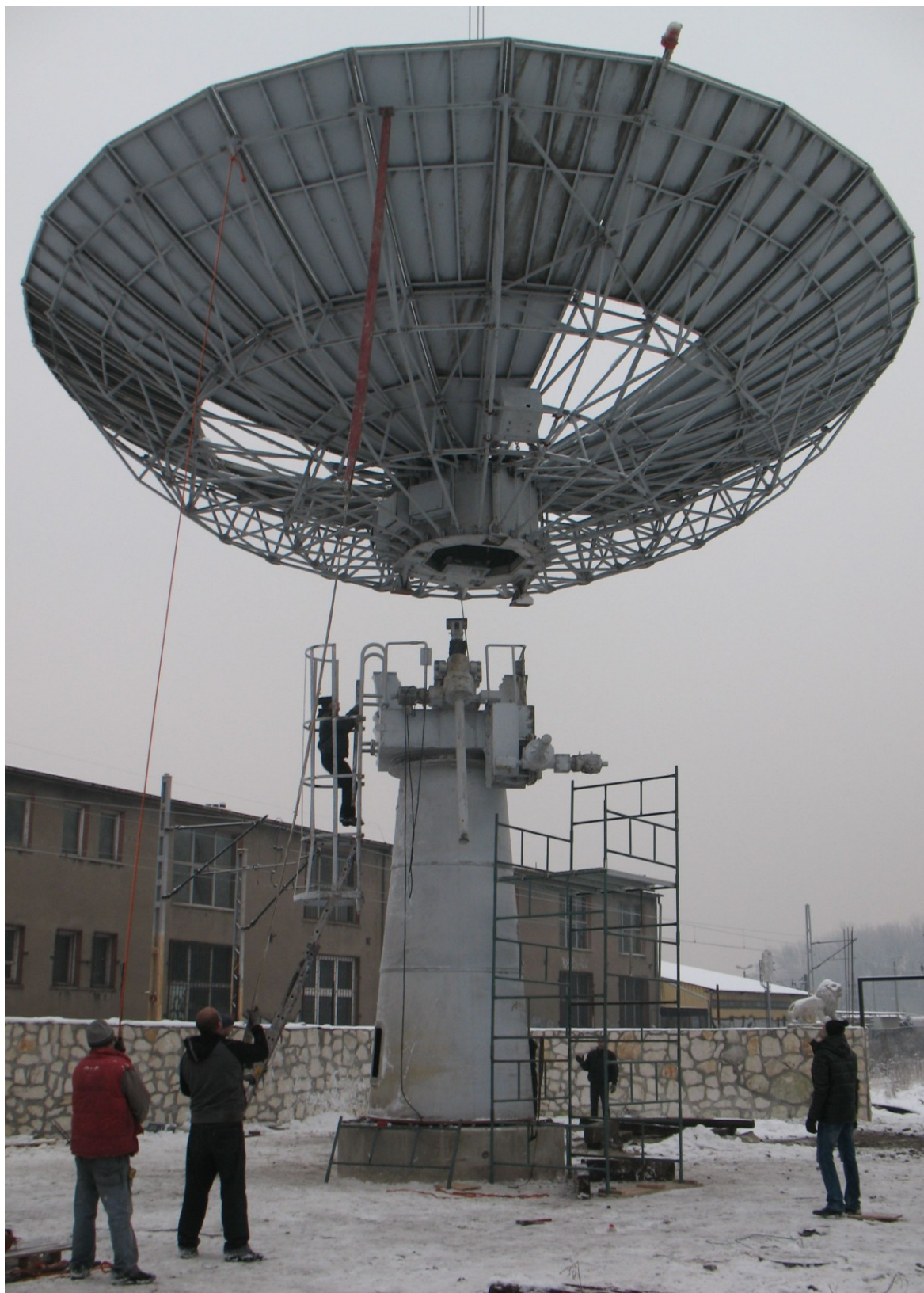
Najbardziej niebezpieczna operacja mocowania czaszy do jej podstawy (nogi). (fot. K.Bączek)
