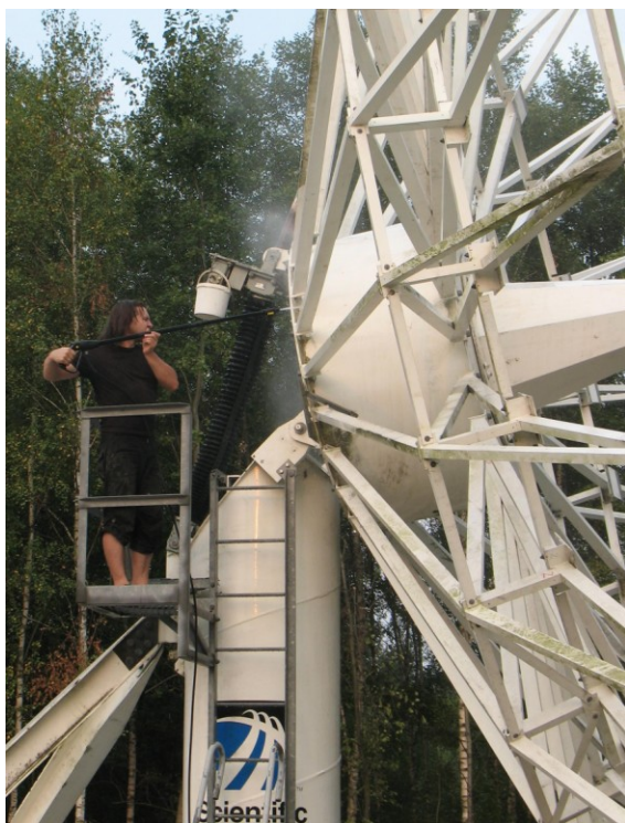
Piotr Beściak w akcji czyszczenia szkieletu czaszy. (fot. B. Wszolek)
