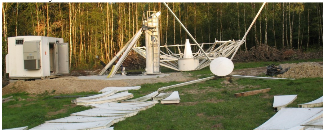
Szkielet czaszy przygotowany do montażu na słupie. (fot. B. Wszolek)
